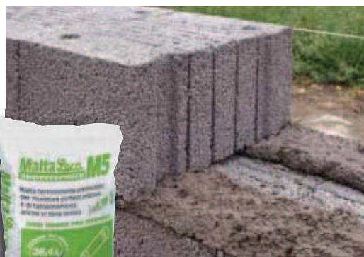
Parete in Bioclima 38 Superlight posata con Malta Leca M5 Supertermica.
